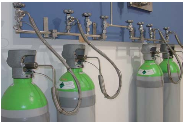
Kit de control de presión y caudal para la inertización de depósitos
