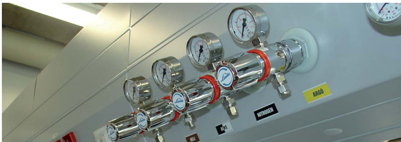
Puestos de consumo para gases de alta pureza empleados en instrumentación analítica
