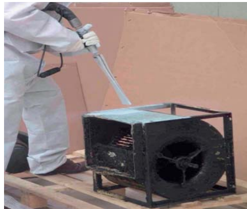
Aplicación de hielo seco en el limpiado y desengrase
