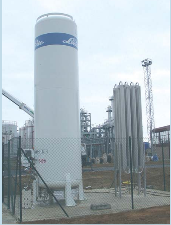
Suministro de nitrógeno para la planta de biodiesel en Caparros
